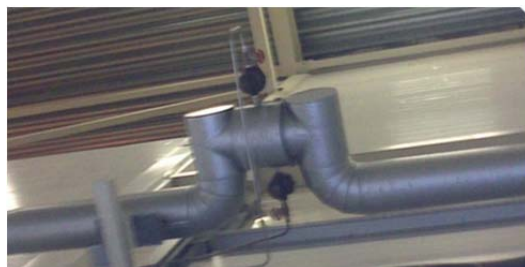
Kuva 23. Kuvassa oleva laippa on asennettu juuri kahden mutkan väliin, ilman suoria putkiosuuksia laipan ympärillä, vaikka suoraa putkiosuutta olisi seinustalla ollut kymmeniä metrejä.
